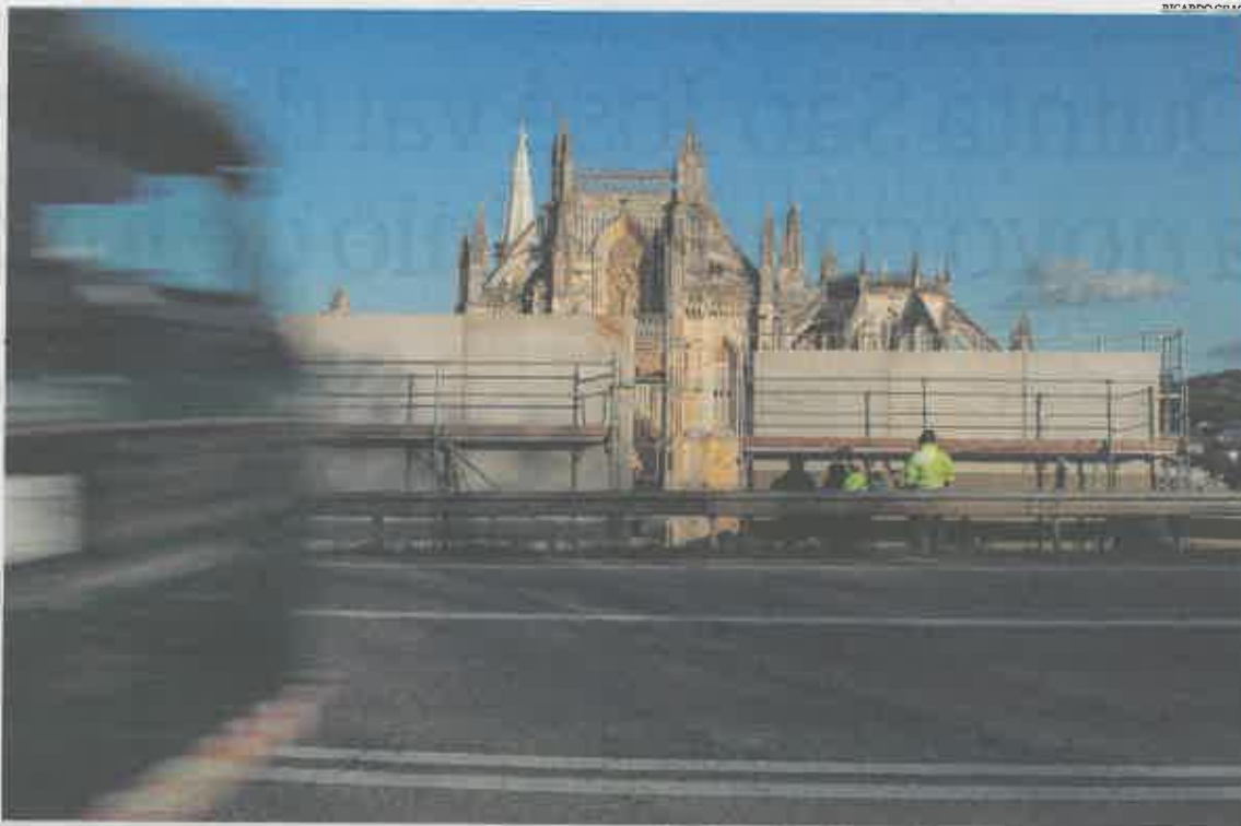
As obras de protecção do mosteiro deverão estar concluídas no final do próximo mês
