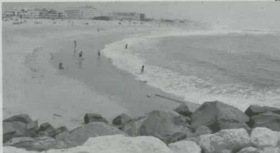
Orla Costeira da região, nomeadamente a Praia da Vieira, poderá ser prejudicada com a construção dos esporões construídos de Leixões para Sul
