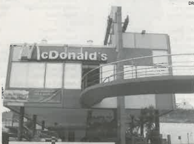
Restaurante situa-se junto à rotunda do Rotário
