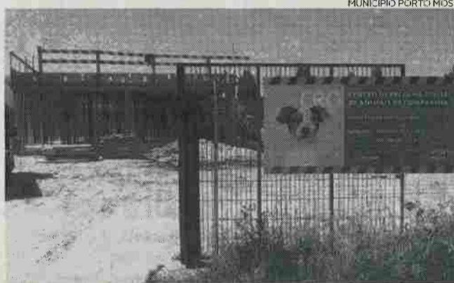
Centro de recolha fica localizado na zona industrial
