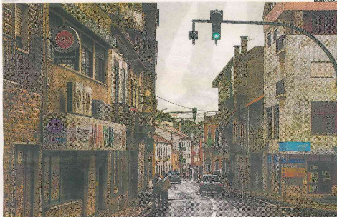
É ao longo da EN243, que atravessa a vila, que se localizam muitos dos edifícios a necessitar de obras
